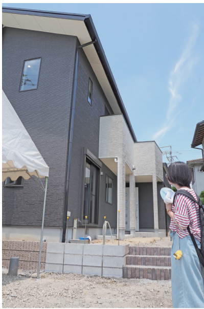
▲完成間近のリノベーション住宅
